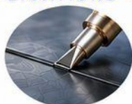
Geomembrane repair
